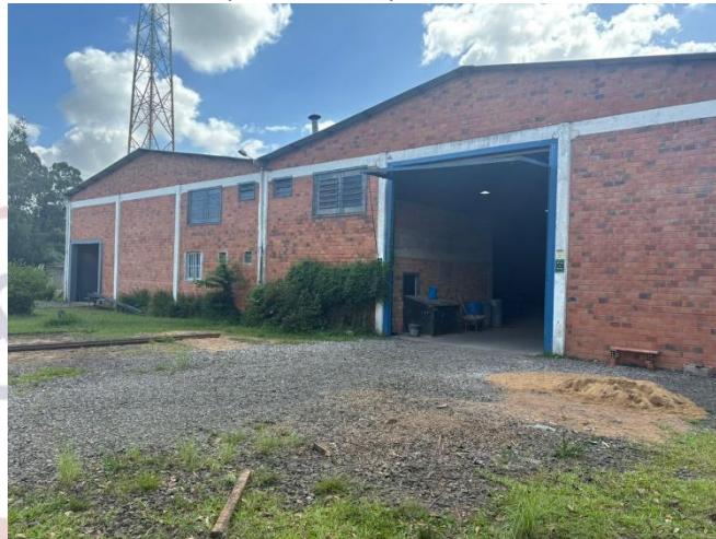
Vista da fachada oposta
