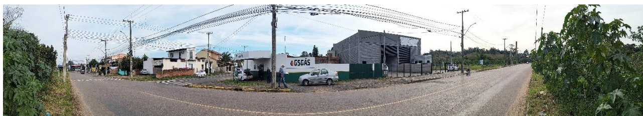
Fig. 6 – Panorâmica Vista Frontal da empresa GS DISTRIBUIDORA DE GÁS E ÁGUA. – Sentido Leste/Oeste
